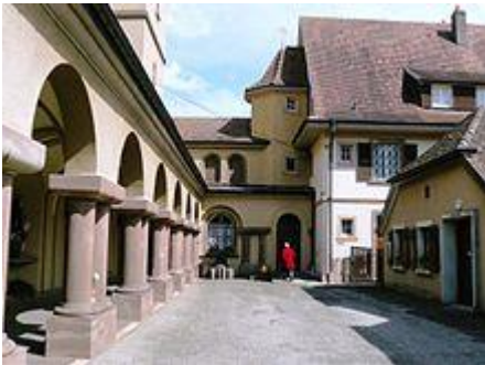
Une partie de l'ancien cloître du Prieuré de Thierenbach
